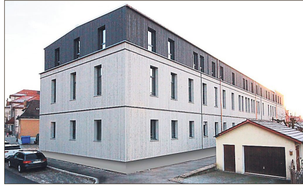
Sanierung und Aufstockung „Altes Telekomgebäude“ in Deggendorf, Hammerl Architekten GmbH Foto: Stefan Hammerl (Deggendorf)
